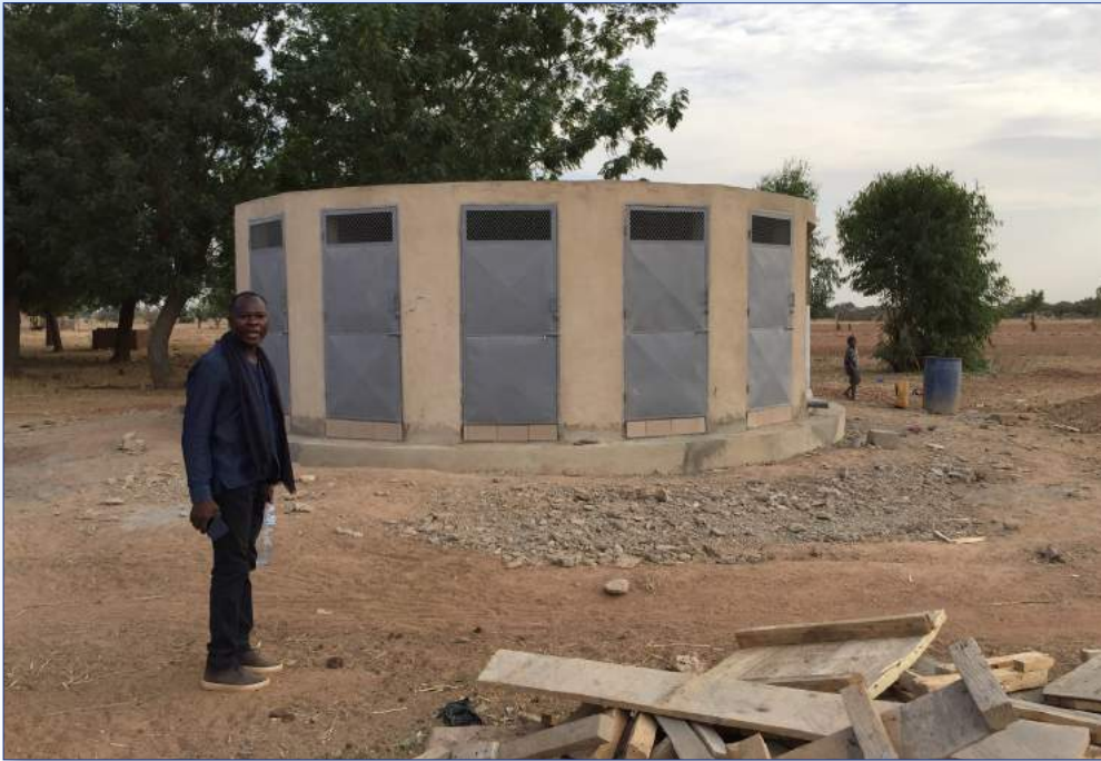
Die Sanitäranlagen in Gando befinden sich noch im Bau
