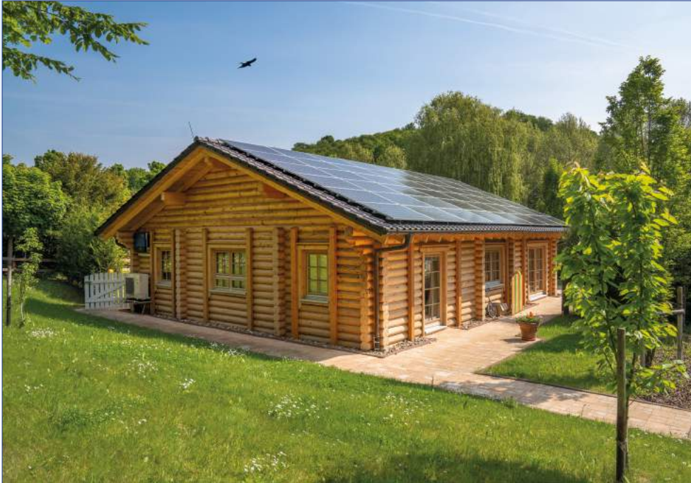
Neue Photovoltaikanlage auf dem Hevert-Kinderhaus
